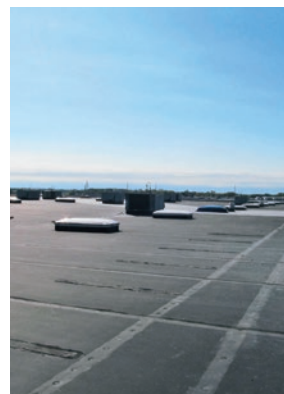
改修前のリンクボール工場屋根
