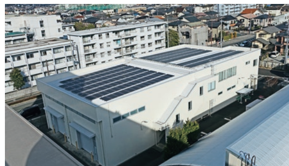
開発棟に設置された太陽光パネル
