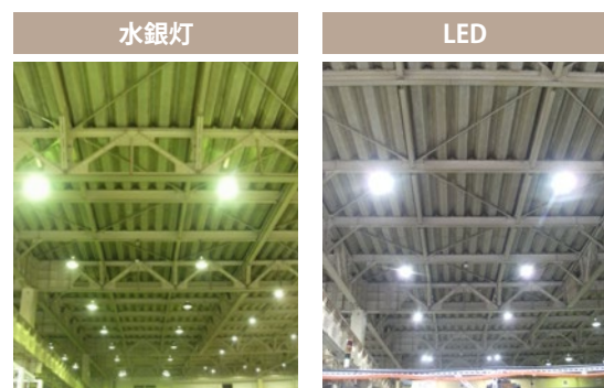
山形工場第1工場
