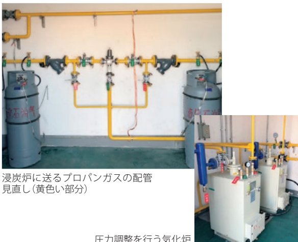
圧力調整を行う気化炉
