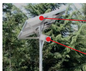
ソーラーパネル付LED照明装置
