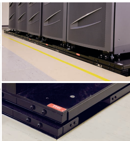
JAL免震サーバー
