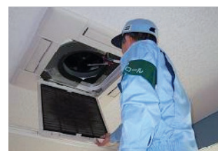
組立室空調フィルタの点検
