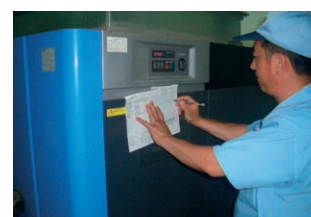
コンプレッサー定期点検
