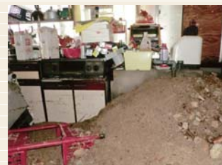
青葉理髪店、土砂流入一階住居部壊滅、土砂搬出救援作業 2013.8.24未明からの短時間の豪雨、私的台業(カンソク)で418mm、豪雨は谷を削り土石流となり、川は溢れ下流の家屋は床上まで土砂に埋まりました
