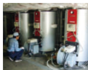
山口工場 ボイラー
