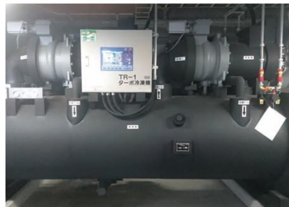
新規に採用したインバータ式ターボ冷凍機
