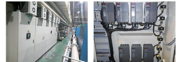
第3工場の集中クーラント装置にインバーター用制御盤を導入
