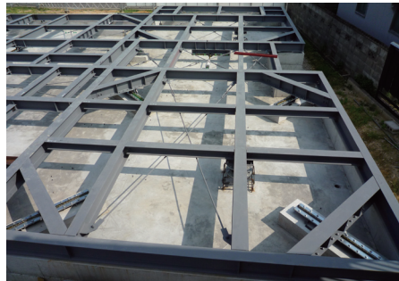
羽根田様邸基礎工事
