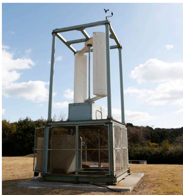
センター敷地内に設置されている改良型小型風力発電
