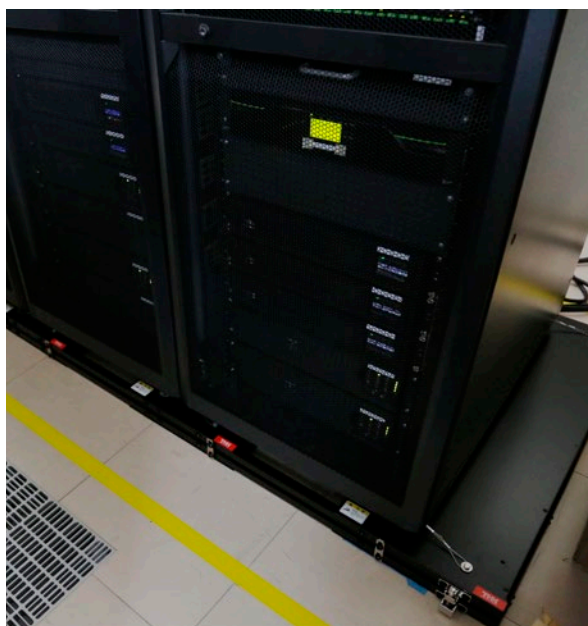
地震によるサーバーラックの倒壊に備えて採用した免震装置
