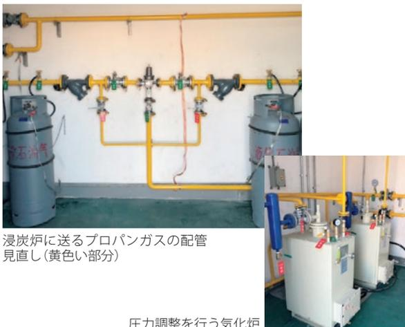
浸炭炉に送るプロパンガスの配管見直し(黄色い部分)
