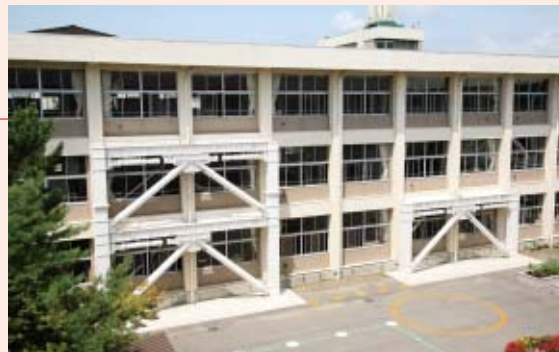
▲減衰こまで耐震補強した秋田市の築山小学校校舎外観
