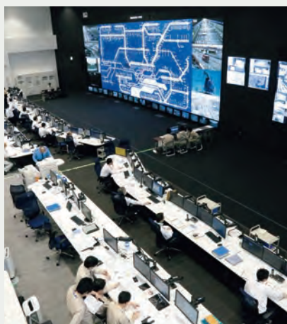
床免震が施された管制官室
