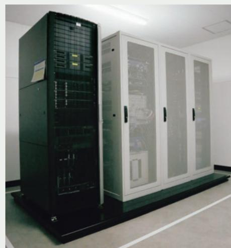
新防災棟に設置した免震を施したサーバー
