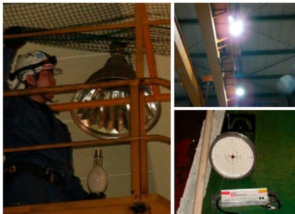
(左) 仙台工場での水銀灯撤去作業
