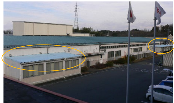
遮熱塗装を行った、左：品質保証課、右：製造第2課現場事務所
