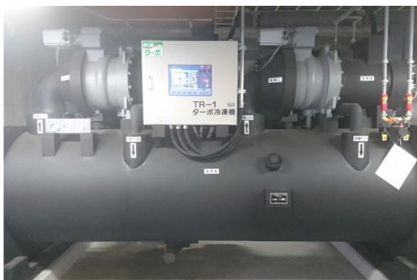
新規に採用したインバータ式ターボ冷凍機
