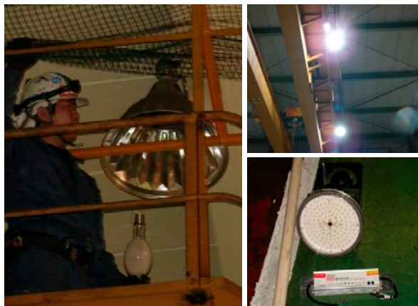
(左) 仙台工場での水銀灯撤去作業 (右上) 切り替えを行ったLED照明 (右下) 新たに設置するLEDライト
