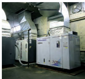
インバータ方式のコンプレッサーを導入(甲府工場)
