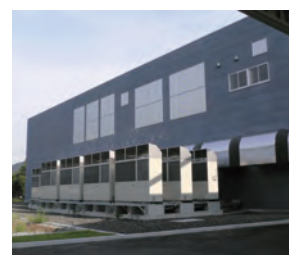
LNG使用のGHP設備 (中部商品センター)
