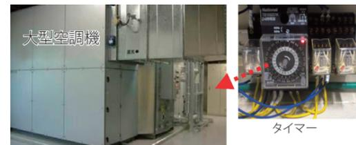
回転速度を変換するタイマーを制御盤に取り付けました。
