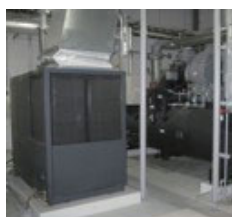
インバーターボ冷凍機
