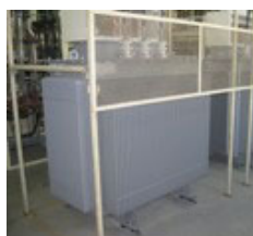
トッランナー変圧器
